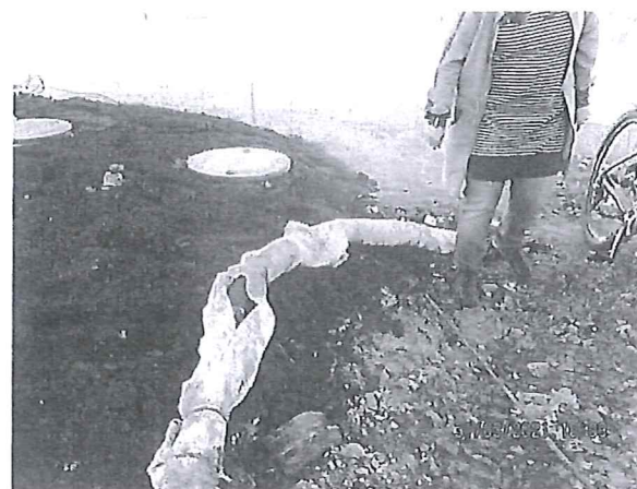
Foto č. 5 a 6 - Drenáž je vadně obalena do geotextilie, zanesení geotextilie není schopno zabezpečit transport vody do drenáže a její další odvádění do recipientu.
